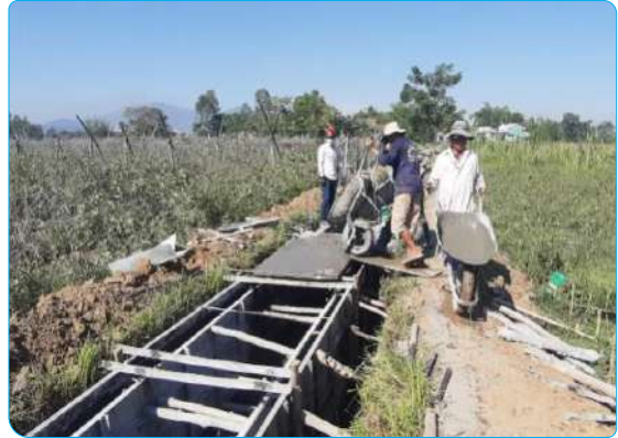
Hình 6.19. Quảng Nam nâng cấp hệ thống thủy lợi
