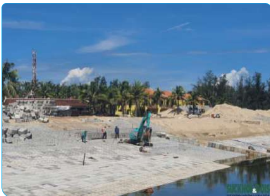
Hình 6.24. Xây dựng các tuyến đê ở bờ biển Hội An
