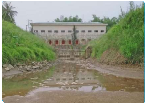
Hình 6.6. Trạm bơm Ái Nghĩa bị cạn nước
