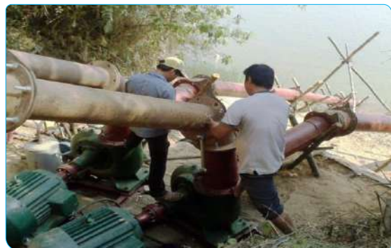
Hình 6.4. Trạm bơm dã chiến được lắp đặt để chống hạn tại huyện Duy Xuyên
